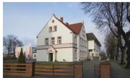
Kompleks szkolny w Nierodzieju – zwycięzca głosowania internetowego Life Challenge 2018 w kategorii „renowacja termiczna”
