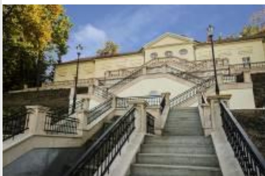
Oranżeria Ignacego Krasickiego w Lidzbarku Warmińskim – Fasada Roku 2015 i Wyróżnienie Internautów w kategorii „budynek po renowacji”
