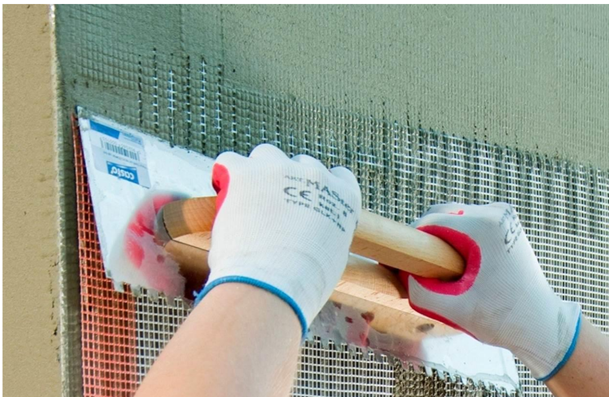
Zatapianie siatki w zaprawie klejowo-szpachlowej | Fot. Baumit
