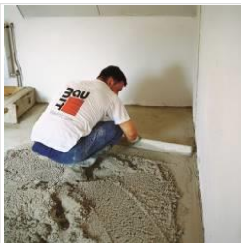
Wykonanie szybkowiążącej posadzki cementowej Rapido 1 Speed
