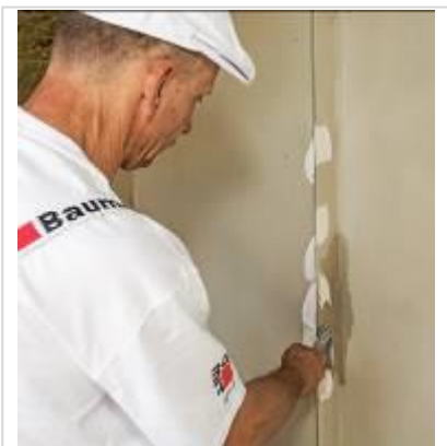
Szpachlowanie narożników przy użyciu gipsu FinoFill
