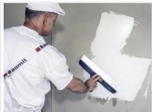
Nakładanie gładzi FinoFinish S
