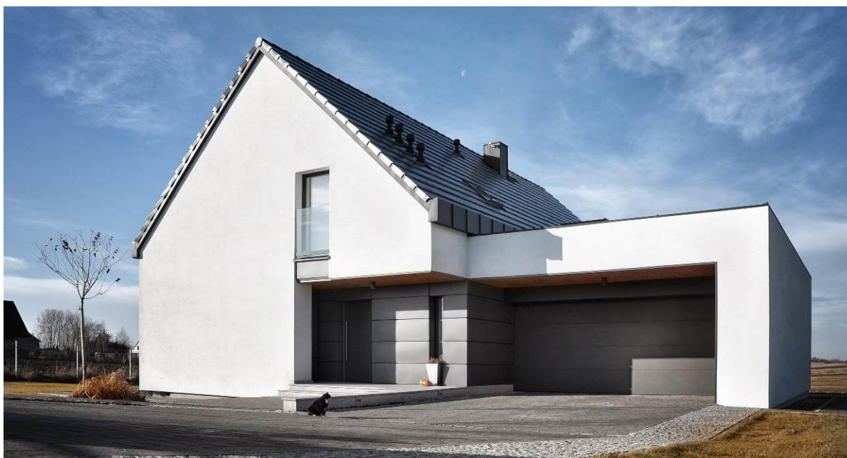
Dom jednorodzinny w Jerzmanowicach, fot. Baumit
