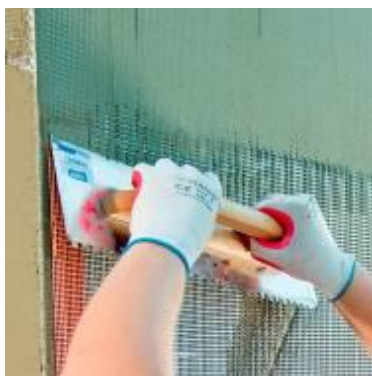
Montaż i szpachlowanie płyt styropianowych zaprawą klejowo - szpachlową Baumit StarContact Speed, Fot. Baumit
