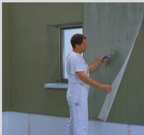
Siatka z włókna szklanego musi być całkowicie zatopiona w zaprawie klejowo-szpachlowej
