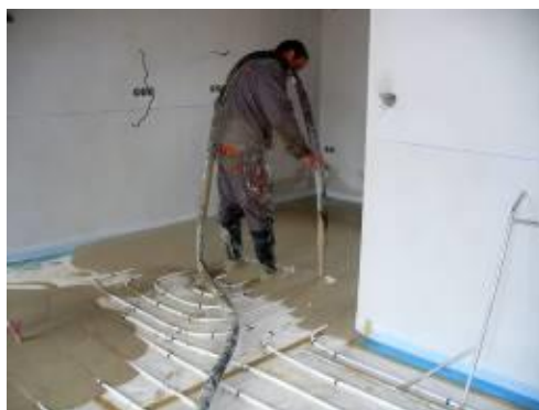
Najkorzystniejszą alternatywą do zastosowania w podkładzie pod dekoracyjną warstwę wierzchnią są jastrychy płynne na bazie gipsu alfa
