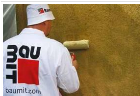
Ręczne oczyszczanie elewacji przy użyciu Baumit FacadeCleaner
