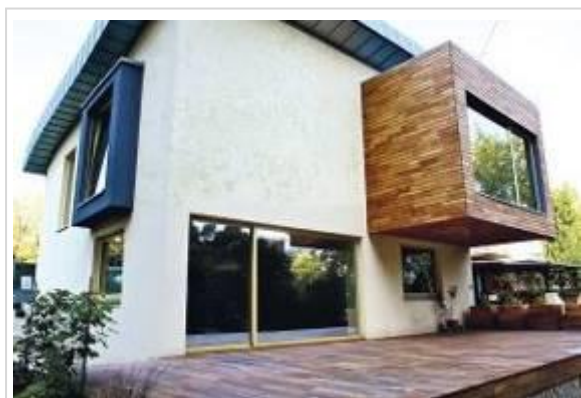
Elewacja zaatakowana przez mikroorganizmy
