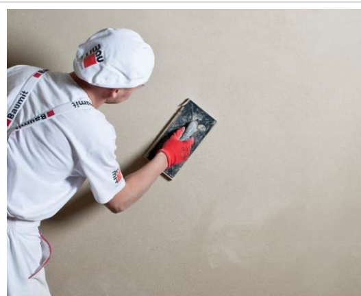
Zacieranie końcowe powierzchni tynku cementowo-wapiennego pacą z twardej gąbki.
