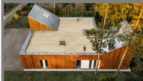
Dom jednorodzinny w Kuźnicy Kiedrzyńskiej – Fasada Roku 2018 w kategorii „budynek jednorodzinny nowy | Fot. Baumit & Grupa Verso Deltoid
