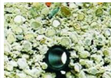
Przekrój tradycyjnego jastrychu cementowego z przewodem grzewczym
