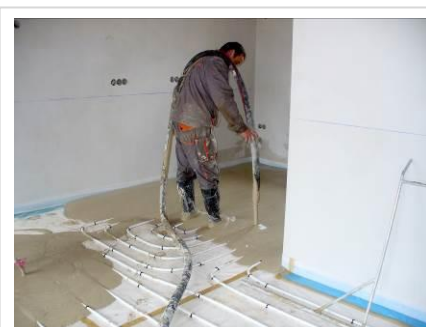
Płynne jastrychy są idealnym uzupełnieniem systemu „cieplej podłogi”
