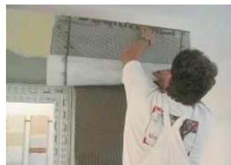
Zatopianie siatki Baumit StarTex dla wzmocnienia podłoża
