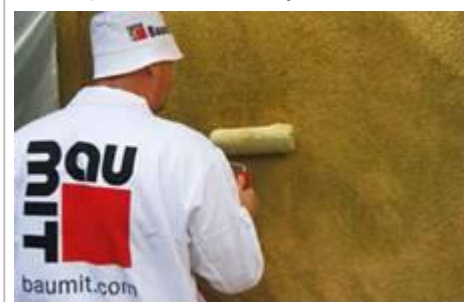
Oczyszczanie elewacji przy użyciu Baumit FacadeCleaner
