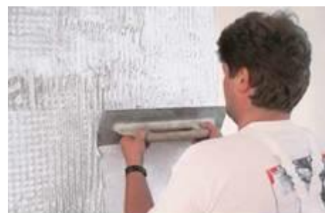
Aplikacja zaprawy klejowo-szpachlowej lub zaprawy przyczepnej
