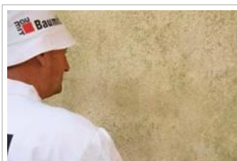
Analiza powierzchni elewacji
