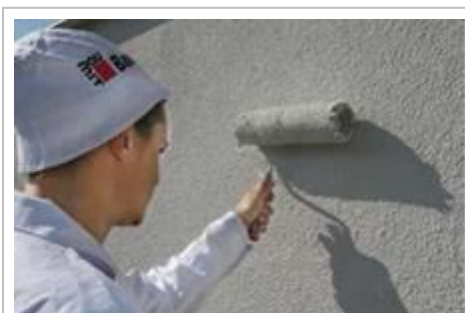
Aplikacja farby elewacyjnej Baumit
