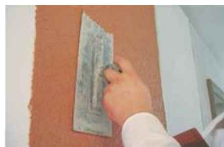
Aplikacja tynku strukturalnego Baumit
