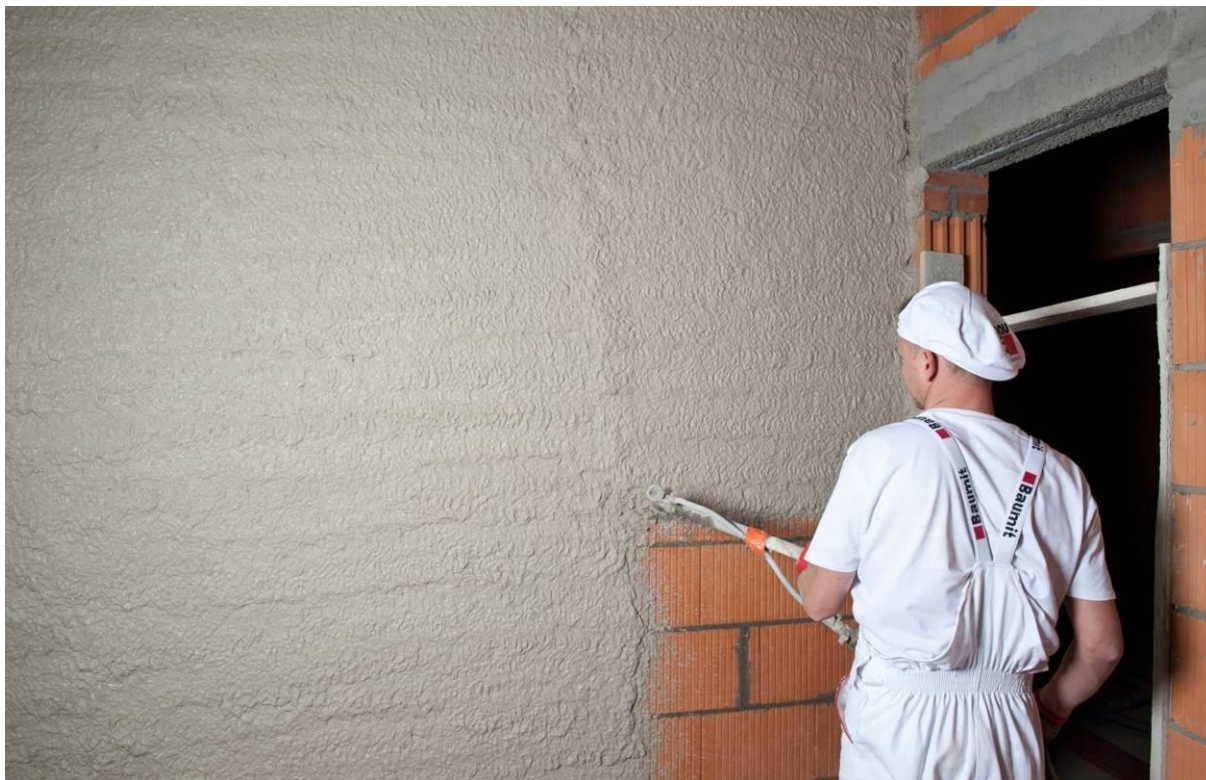
Narzucanie tynku cem-wap agregatem | Fot. Baumit
