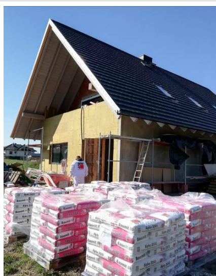
Samopoziomujący podkład podłogowy Baunit Alpha 2000 na budowie Domu Optymalnego
