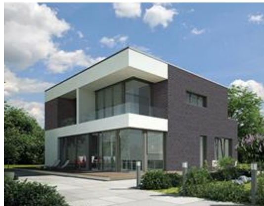
Trójwarstwowa ściana z elewacją z cegły klinkierowej Galaxy firmy CRH Klinkier.
