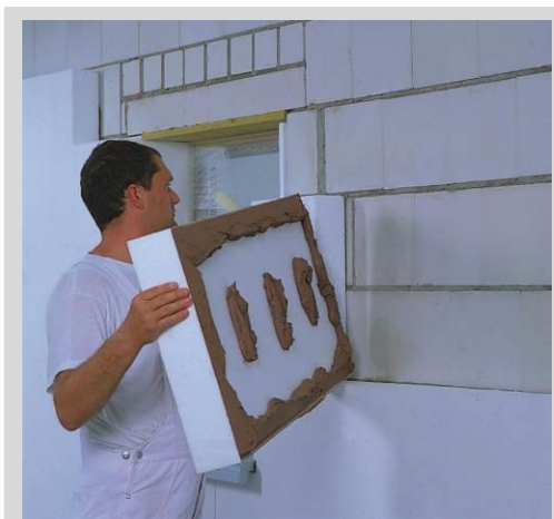
Płyty termoizolacyjne kleimy po obwodzie płyty z dodatkowymi „plackami” wewnątrz
