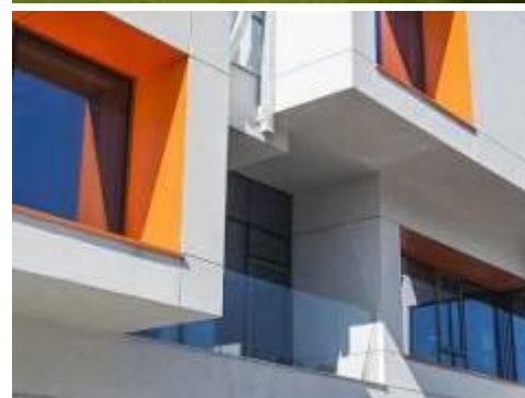
Efekt betonu drobnoziarnistego – Biurowiec Consultronix w Balicach
