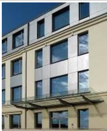
Efekt gładki metaliczny – Centrum Biurowe Podwale w Poznaniu
